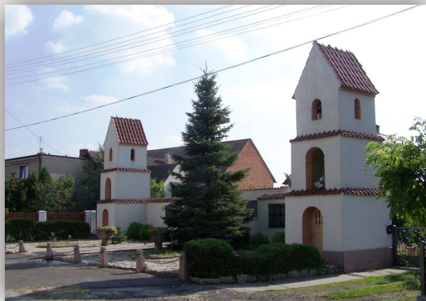
Węgry, kaplica przy ul. Szkolnej
