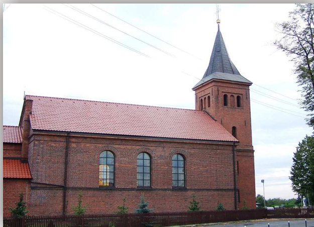
Dobrodzień, Kościół par. rzym. – kat. p.w. Nawiedzenia NMP, ul. Ks. Gładysza
