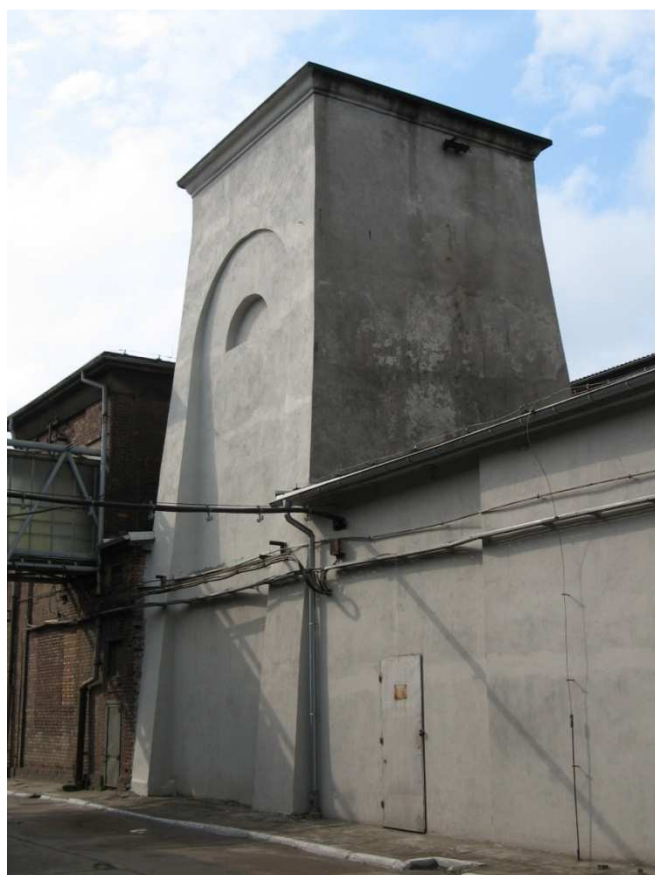
Ryc. 78 Zachowana do dziś na terenie huty w Ozimku wieża, mieszcząca kiedyś urządzenia do nadmuchu, pochodząca z roku 1803.
