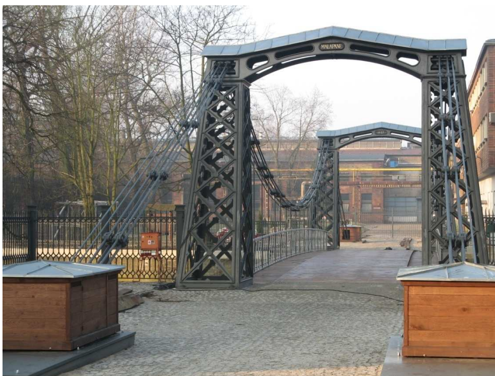
Ryc. 80 Łańcuchowy, żelazny most wiszący w Ozimku jest najstarszym tego typu zabytkiem na świecie. Po remoncie udostępniony jest dla zwiedzających
