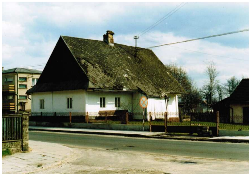
Ryc. 84 Dom Miksów przy ulicy Wyzwolenia 1 pamięta początki hutniczej kolonii. Niestety dziś już znajduje się w bardzo złym stanie
