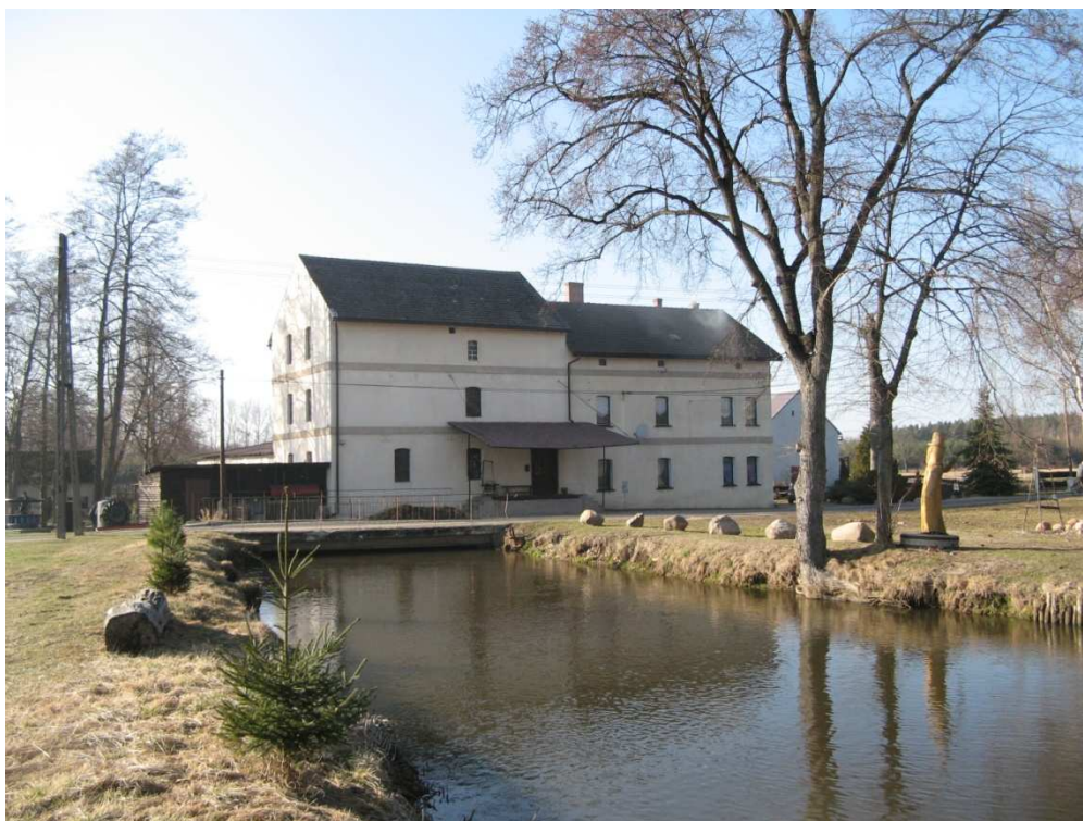
Ryc. 36 Młyn rodziny Thiel nie pełni już dziś swojej pierwotnej roli, ale nadal pracują w nim nowoczesne turbiny, wytwarzające energię elektryczną
