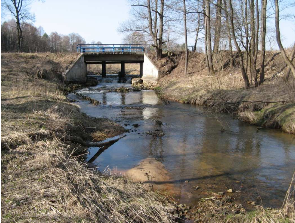
Ryc. 122 Jeszcze dziś różnica poziomów na istniejącej zaporze na Lublinicy w Liszczoku, mimo że staw przed nią jest pozbawiony wody, pokazuje ile można było uzyskać energii potrzebnej do napędu urządzeń hutniczych
