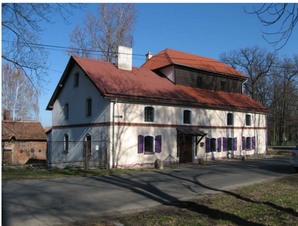
Ryc. 100 Niewiele pozostało śladów dawnych urządzeń wodnych w dobrach turawskich. Poza ledwo dostrzeganymi zarysami stawu pałacowego, resztkami kanałów, zachował się budynek młyna
