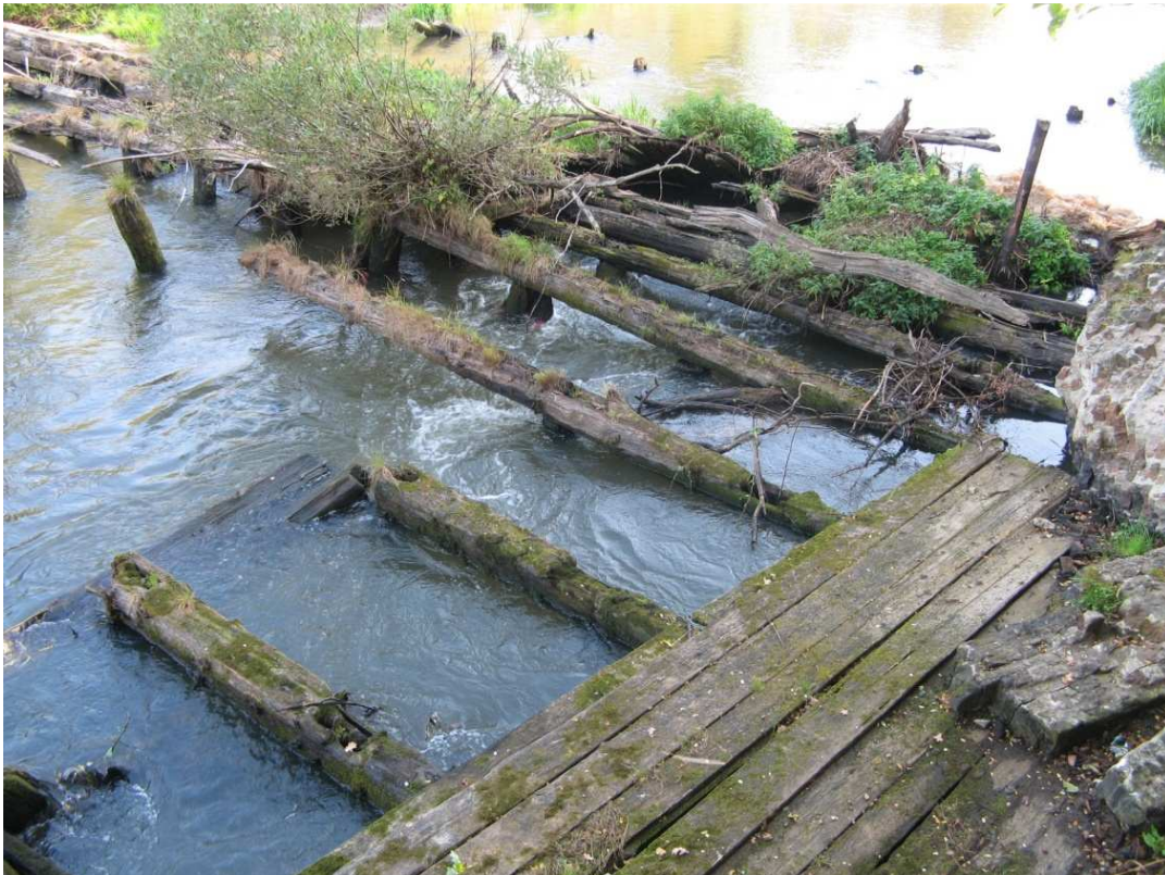
Ryc. 74 Pozostałości wykonanej z dębowego drewna zapory na rzece Mała Panew, spiętrzającej jej nurt na potrzeby huty w Krasiejowie
