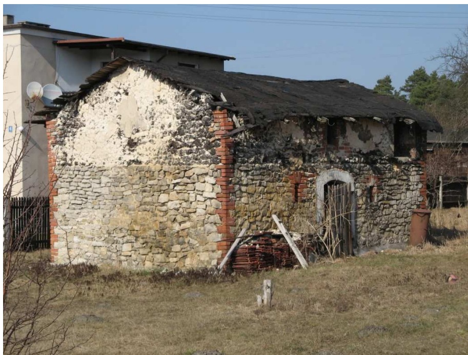
Ryc. 126 Stary budynek gospodarczy w Pietraszowie, który częściowo został zbudowany z brył żużlu hutniczego
